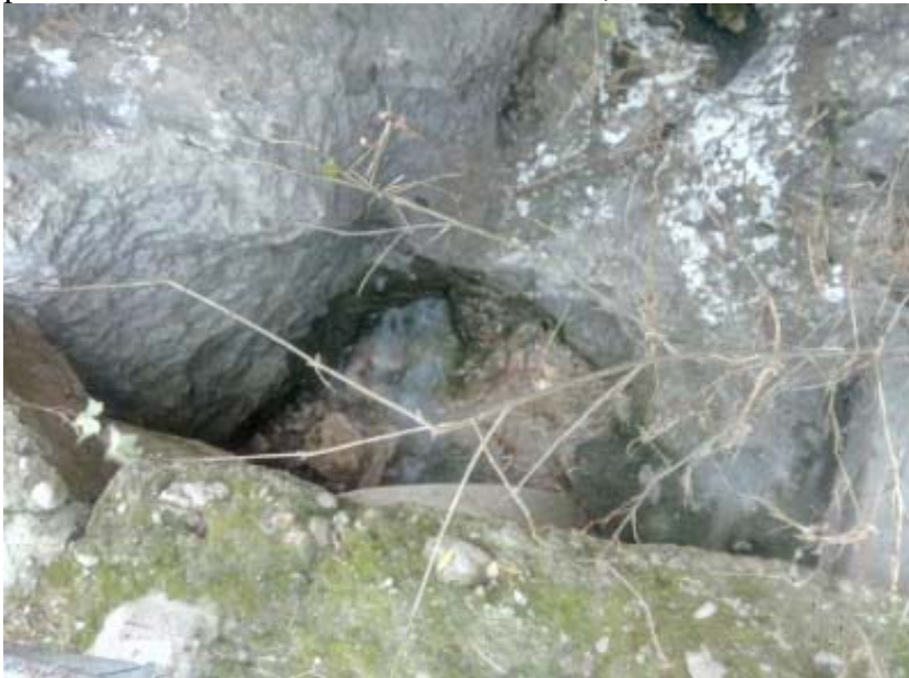
Photo 1 : Résurgence Diaclase (parapet béton et buse sous la route)
